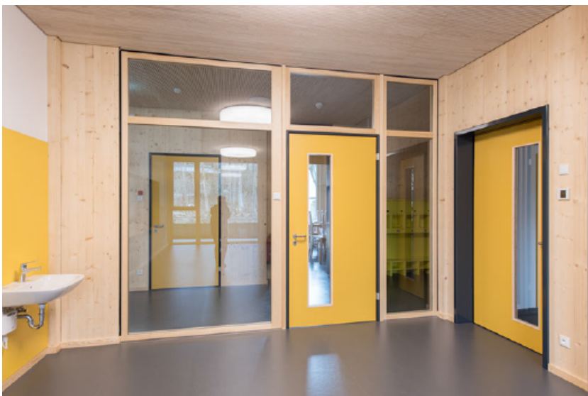
3321 // Bildtext 4: Sowohl Umfassungs- als auch Profilzargen in Kombination mit Massivholzzargen sowie umlaufende Festverglasungen aus Holzrahmenprofilen gehören zu den schützenden Türlösungen.
